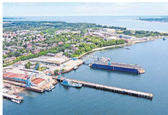
Das Areal der ehemaligen Lindenau-Werft in Kiel gehört der Werft German Naval Yards Kiel (GNVK). Sie sucht einen Käufer für das rund 70 000 Quadratmeter große Gelände. FOTO: ULF DAHL
